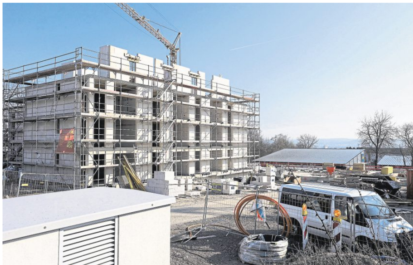
Im Neubaugebiet „Obere Mitte Heddendorfer Berg“ sind die ersten Gebäude schon im Bau. Auf der rund 1,9 Hektar großen Fläche zwischen der Kinzing-Schule und der Ludwig-Erhard-Schule sollen acht Mehrfamilienhäuser mit insgesamt etwa 150 neuen Wohnungen entstehen.
