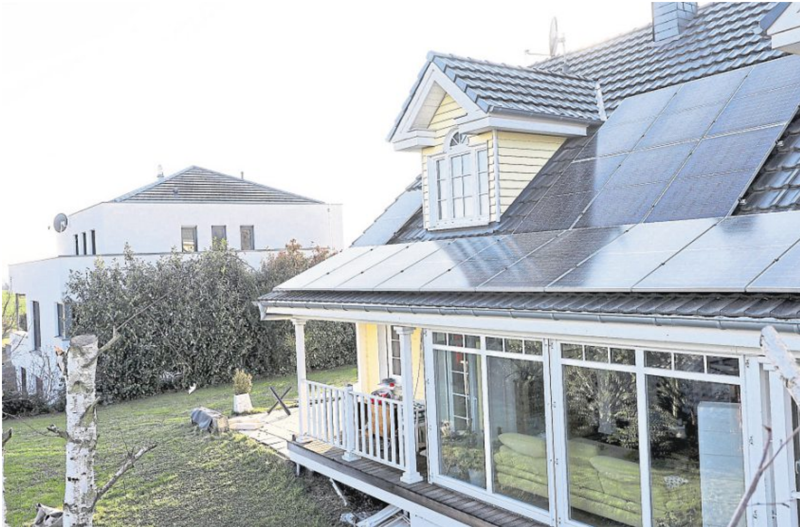
Die Stadt Neuwied soll sich auf den Weg machen, ihre benötigte Energie möglichst weitgehend selbst zu erzeugen. Fotovoltaikanlagen auf Dächern von Privathäusern, aber auch auf öffentlichen Gebäuden und in Gewerbegebieten können dazu einen Beitrag leisten.
